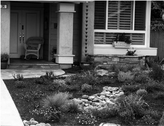
La depresión rocosa que se ilustra está a plomo para captar el agua de los techos y periódicamente se llena de residuos, hojas y malezas. Como todas las depresiones, esta zona de infiltración se debe limpiar año por medio.
