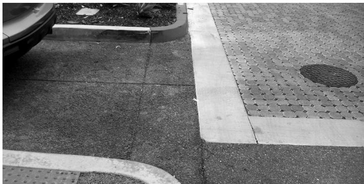
Tanto el concreto poroso como los adoquines requerirán aspirado o barrido periódico para mantener la eficiencia.
