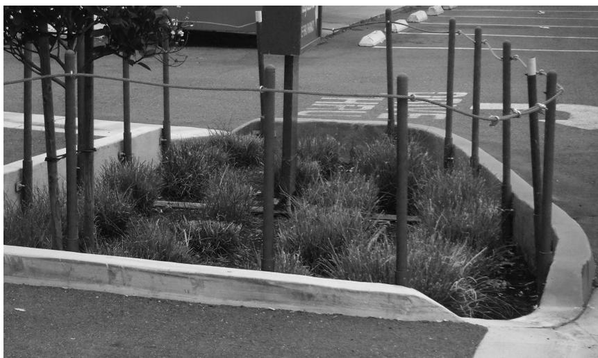
El agua que corre moverá cosas. Las hojas, la basura y los residuos tóxicos todos terminan en las cuentas de infiltración. El mantenimiento es esencial para un sistema con buen funcionamiento y en buen estado.
