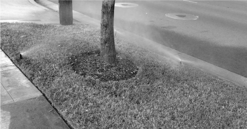
La calle y el acceso vehicular están notablemente mojados. La niebla producida por estos cabezales rociadores ha sido arrastrada por el viento. Se debe reducir la presión del agua y/o reemplazar los cabezales.
