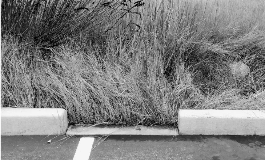
La gestión de las aguas pluviales solo dará resultado si hay un compromiso a largo plazo con el mantenimiento. Las hierbas que bloquean la rampa de la acera en la foto causarán la formación de charcos de agua sobre el asfalto, lo cual acelera el deterioro de la superficie y genera un riesgo público.
