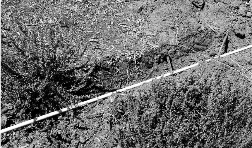
Tubería de emisor en línea instalada un par de pulgadas bajo tierra. Cortesía de Camrosa Water District.
