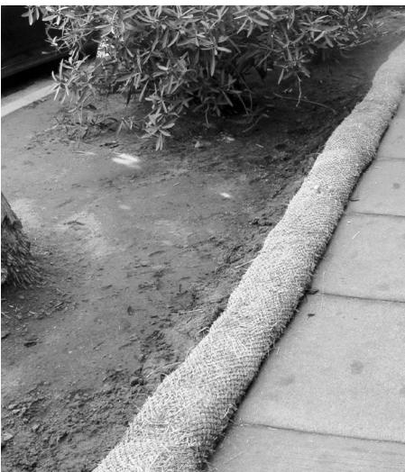
Los rollos de fibra protegen la acera del mantillo de DG. El DG debe quitarse. No solo tiende a desplazarse en las pendientes, sino que se compacta con facilidad y produce escorrentía rápidamente. El DG no es aconsejable en las pendientes.
