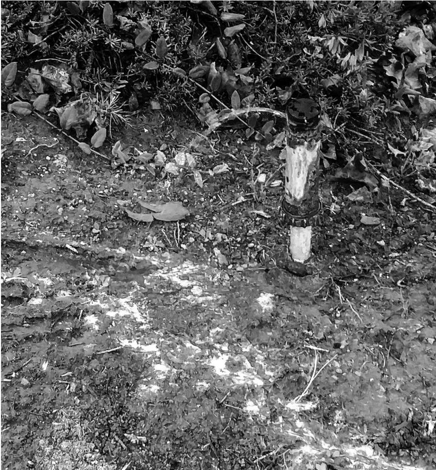
El cabezal rociador que se ilustra sigue goteando agua mucho tiempo después de que la válvula se ha cerrado. Los surcos en el suelo como resultado son obvios. Las soluciones son instalar un cabezal rociador con una válvula de retención, elevar el cabezal o reforzar la pendiente alrededor del cabezal con rocas de drenaje grandes.
