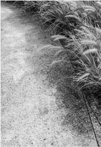
El DG puede adquirir un aspecto barroso con el tiempo. Raspe y retire apenas suficiente DG como para volver al material original. Finalmente, se deberá acarrear nuevo material.
